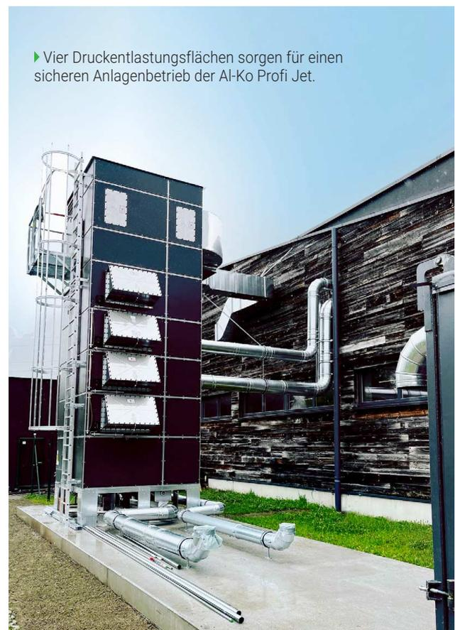
► Vier Druckentlastungsflächen sorgen für einen sicheren Anlagenbetrieb der Al-Ko Profi Jet.
