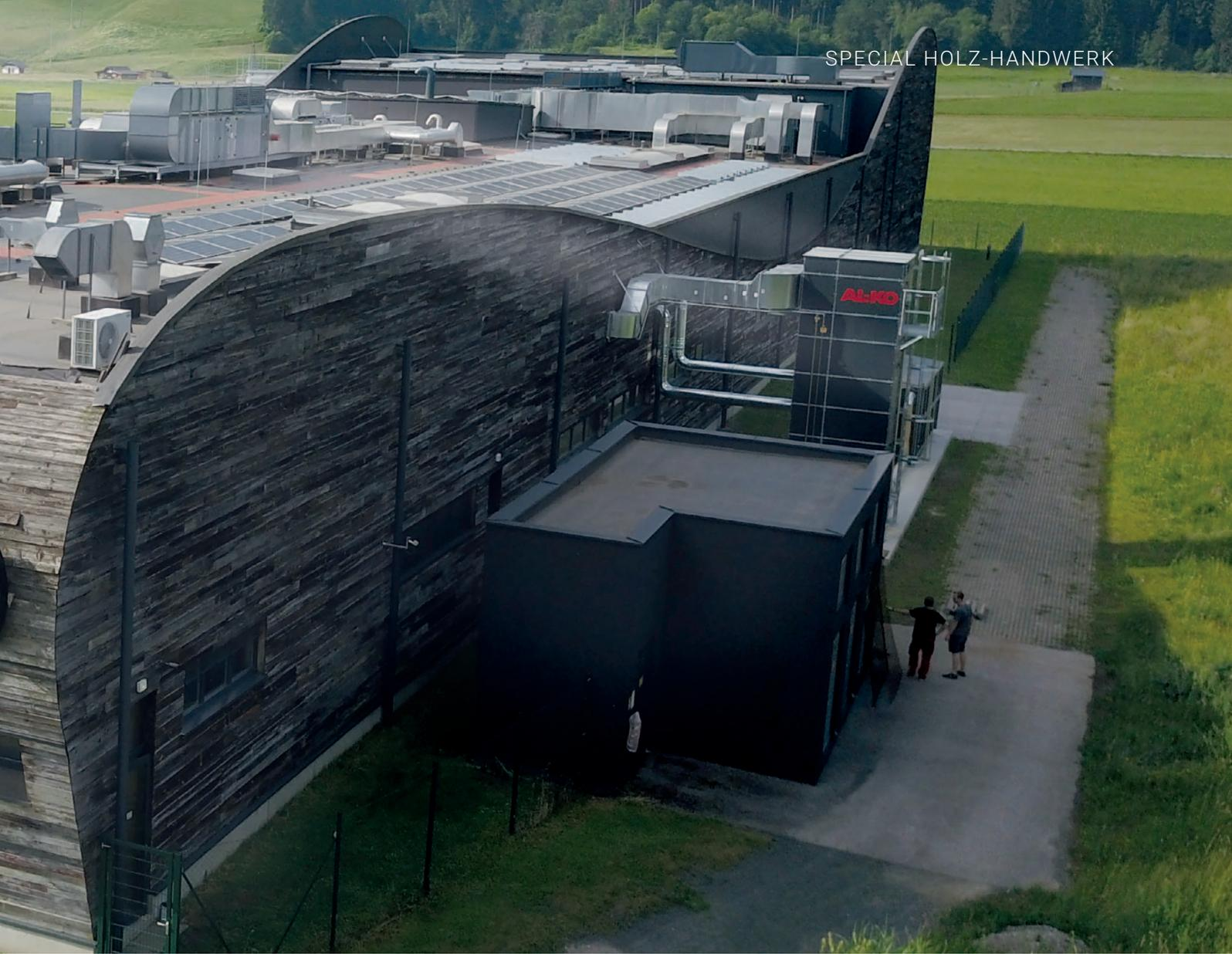
voltaik-Elemente Strom, die restliche benötigte Energie liefert eine Flusswasserwärmepumpe am benachbarten Fluss Gail.
