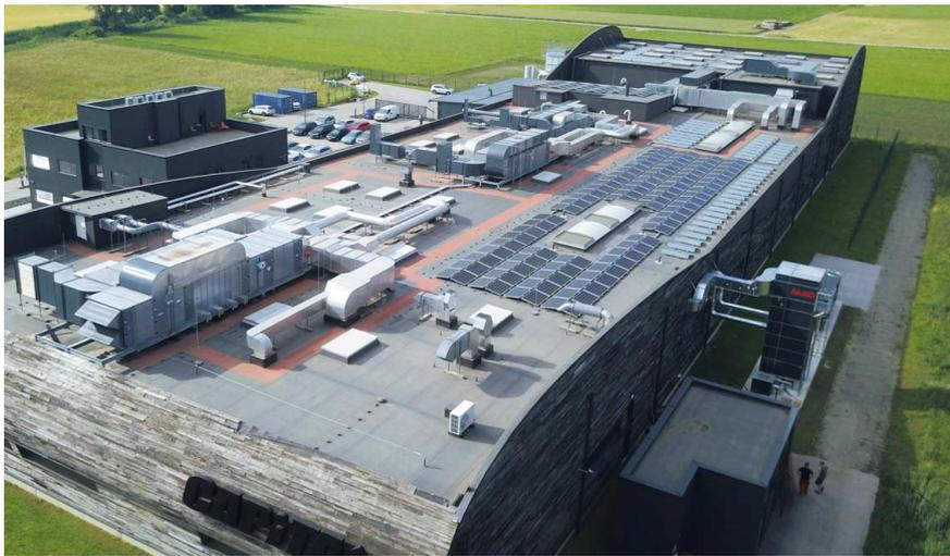
► Auf dem Dach erzeugen Photovoltaik-Elemente Strom, die restliche Energie stammt aus einer Flusswasserwärmepumpe am Fluss Gail.
